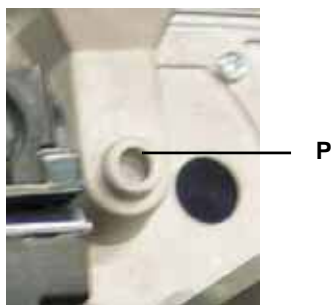
Штуцер для замера давления воздуха вентилятора
